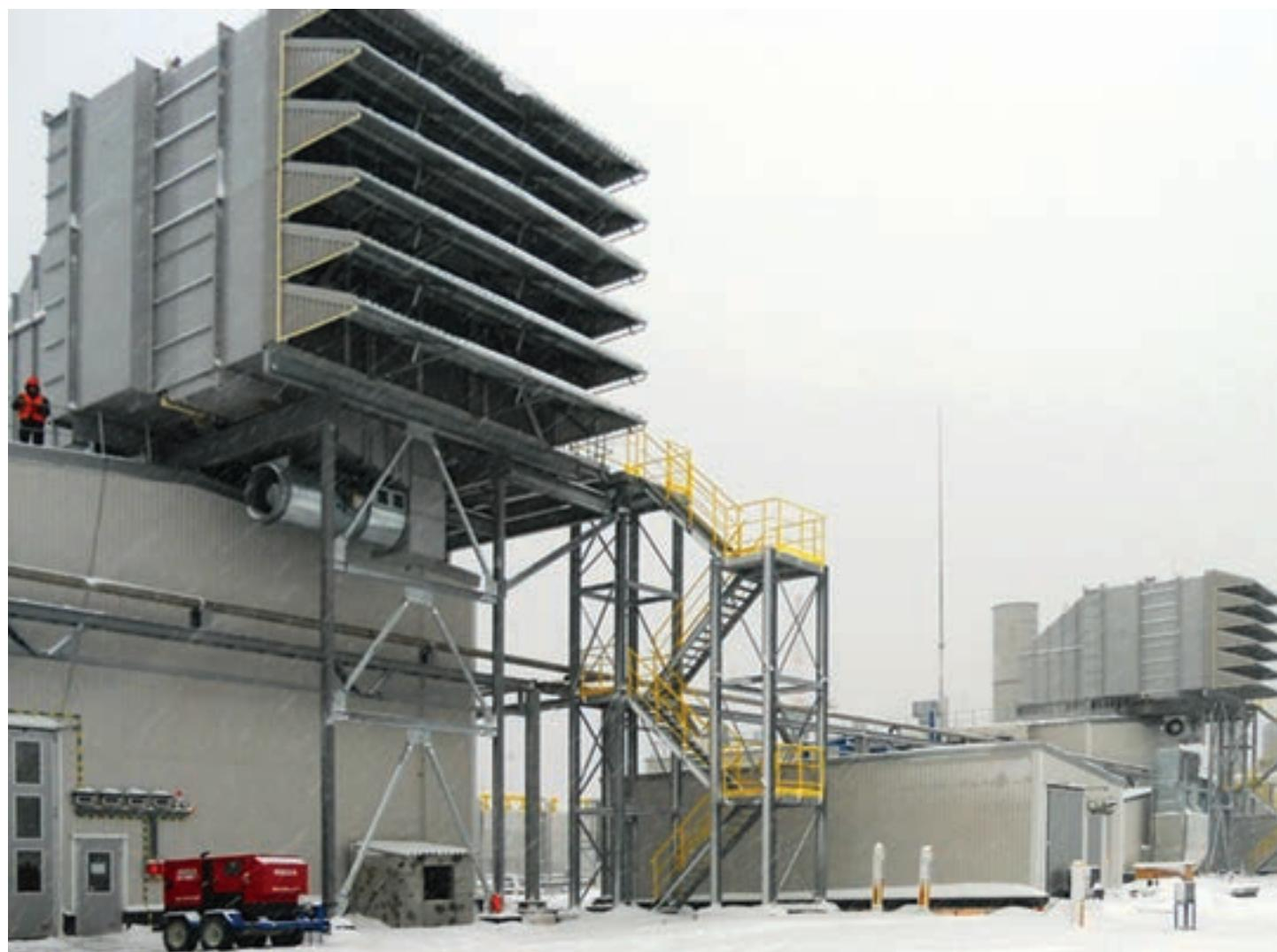
Рис. 7. Импульсное КВОУ с самоочищающимися фильтрами ASC компании AAF для газовой турбины Trent60 мощностью 50 МВт компании Rolls Royce. Компрессорная станция «Портовая» магистрального газопровода «Северный Поток»
