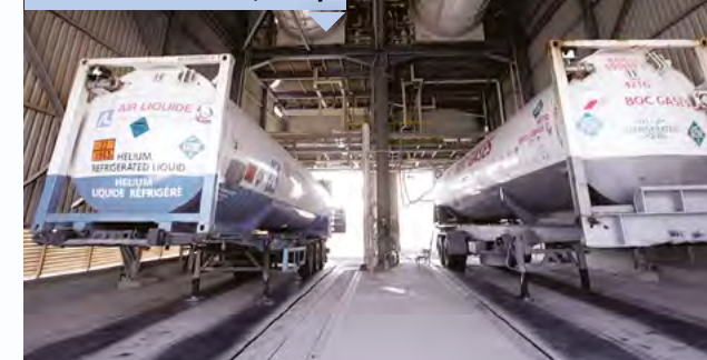
Гелиевый завод Ras Laffan Helium Plant, Катар
