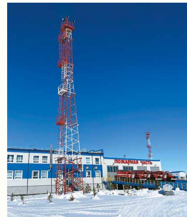
Рисунок 1. Здание ведомственной пожарной части
