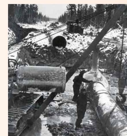
Строительство магистрального газопровода Игрим — Серов, 1965–1966-е годы, «Газпром»
