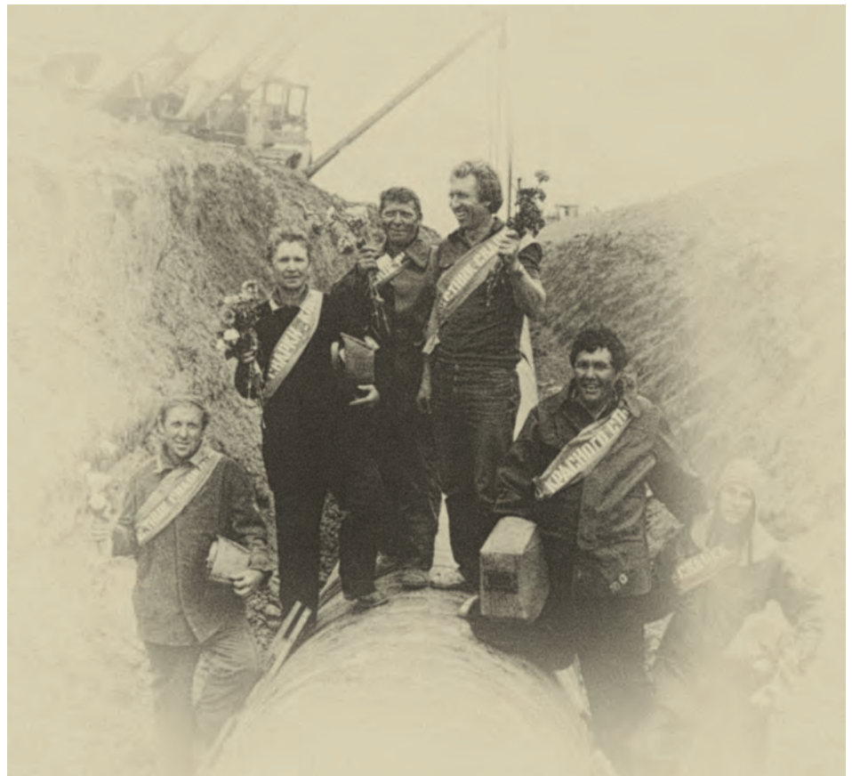
На строительства газопровода «Уренгой — Помары — Ужгород» в Винницкой области Украинской ССР. 1983 год
