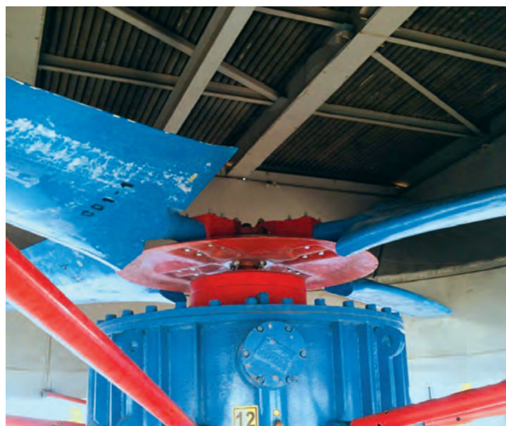
Фото 2. Композитное рабочее колесо ГАЦ-50-4М2
